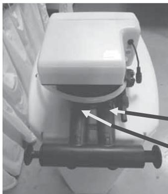
Umístění by-pass je v zadní části hlavice změkčovače.
